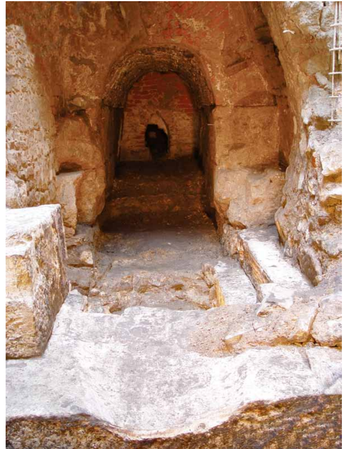
Kleine Budengasse/Ecke Unter Taschenmacher. Auslass des römischen Hauptsammlers in die Rheinniederung.
